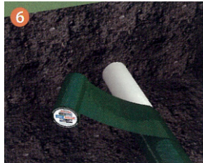
Yeraltı boruları korumalarında
